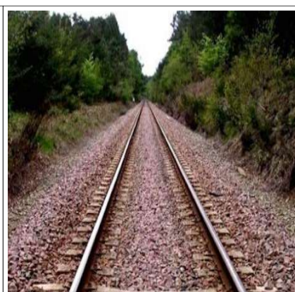
Très belle voie en alignement avec rail sur traverses béton. On distingue bien la première traverse un peu découverte, et les autres donnant l'impression que la voie est montée sur plots
